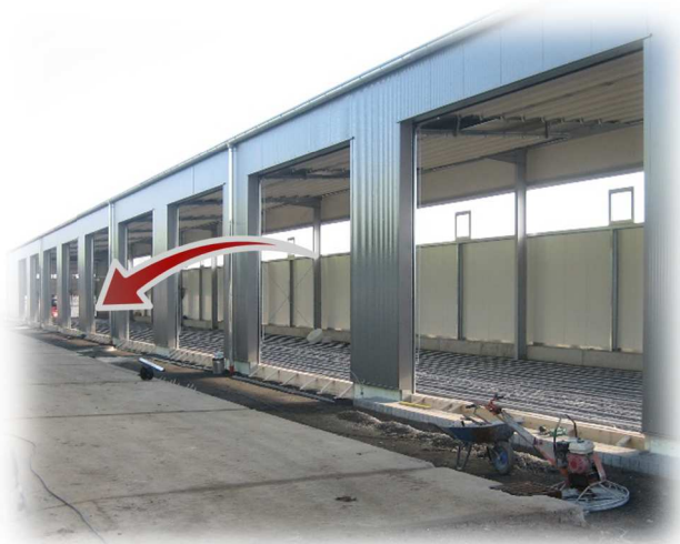
Hallentore über die gesamte Front des Gebäudes lassen beim Öffnen schnell die warme Raumluft entweichen.
